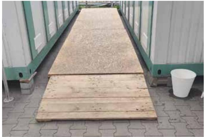
Le parquet de propreté posé sur palettes rendait l'accès impossible aux fauteuils roulants. Une rampe d'accès a donc été réalisée pour permettre aux personnes à mobilité réduite de se rendre aux douches.
