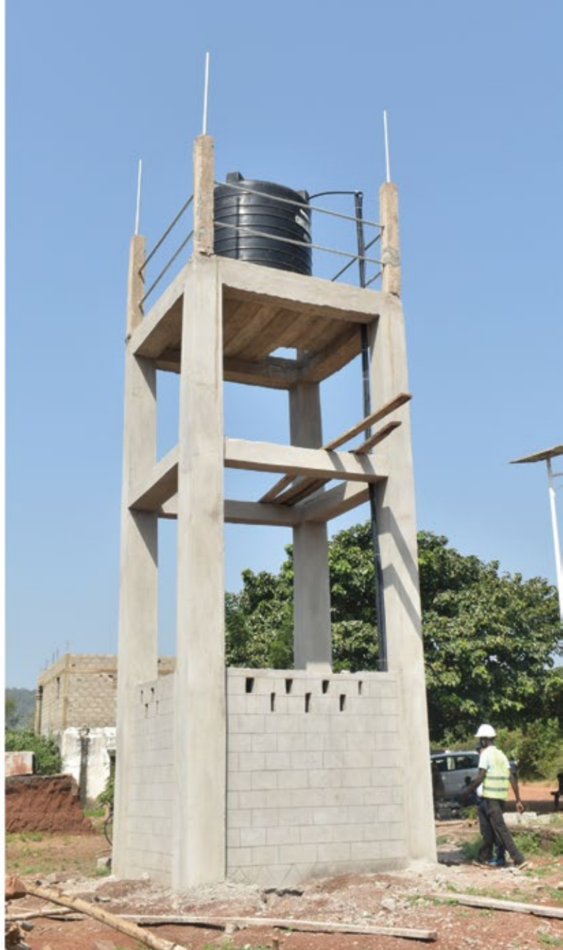
Forage et construction d'un PEA
